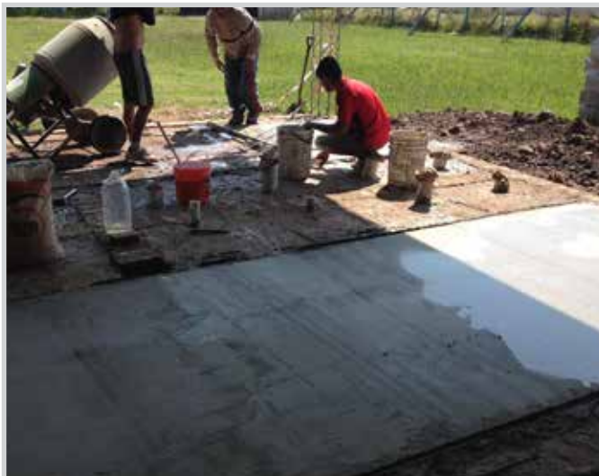
Contra piso y desagüe de baños para niñas y niños. Listo para levantar paredes. The underlayment and drain for bathrooms for girls and boys. Ready for walls.
